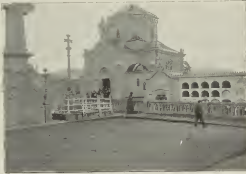
Masnou (Barcelona).—Capilla panteón para pobres, regalada á la villa del Masnou por el hijo de la misma D. Buenaventura Fontanills. Obra del arquitecto D. Buenaventura Bassegoda. (De fotografía de A. Merlett.)
